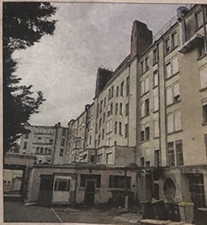
Dans le projet, le bâtiment principal de l'ancienne clinique Trarieux devrait être réhabilité Photo Progrès/Aline DURET.
