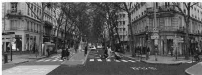
Perspective de la ligne 12 sur le Cours Gambetta depuis la Place Gabriel Péri.
