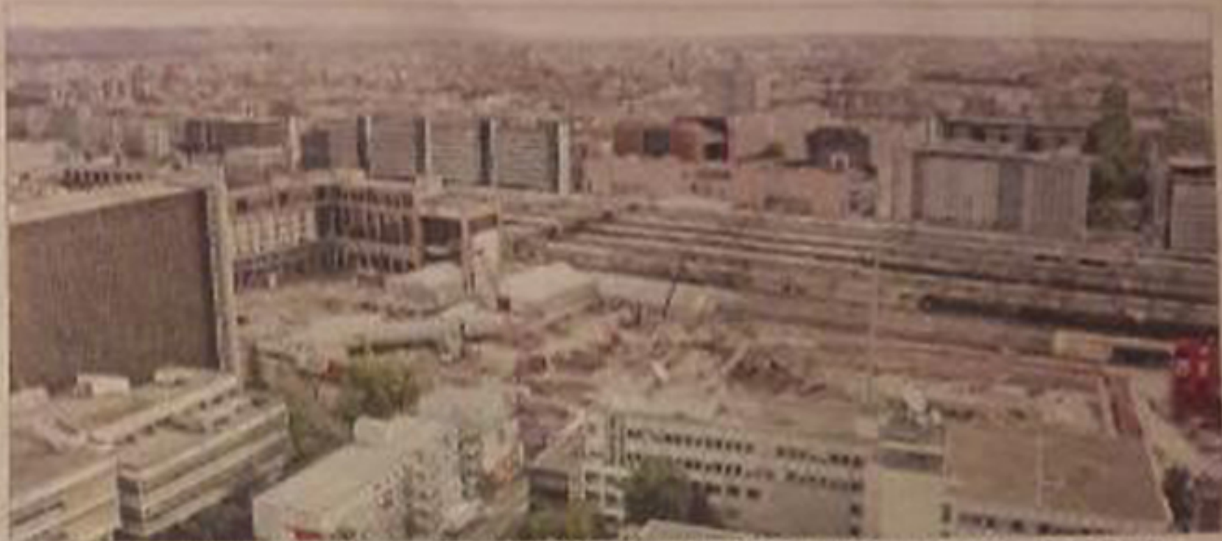
À la Part Dieu, rue Bouchut. C'est ici, le long de la bibliothèque municipale, en lieu et place des bases de vie et de la gare, que sera plantée une forêt urbaine. Photo Progrès/Richard MOUILLAUD
